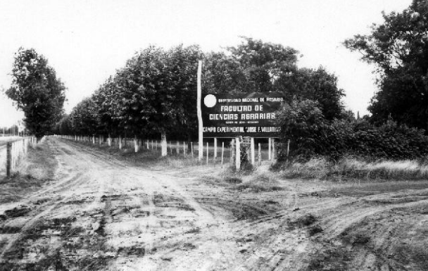
Foto 2: El Campo Villarino en la década del '70. Por este esquinero entraban los estudiantes, que venían caminado desde la Ruta 33 o la estación de ferrocarril de Zavalla.
